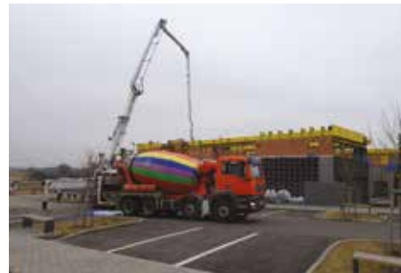
Stavba základní školy v roce 2018
