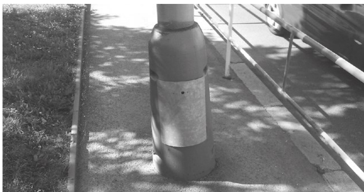
[ obr. 10 ] Umístění stožáru veřejného osvětlení v chodníku způsobem, který brání pěšímu pohybu
