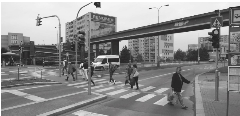
[ OBR. 12 ] Nevhodně řešené mimoúrovňové křížení pěšího pohybu s komunikací. Pro nefunkčnost byl nejprve paralelně zřízen úrovňový přechod a nakonec nadchod zcela odstraněn. Jižní Město, Praha
