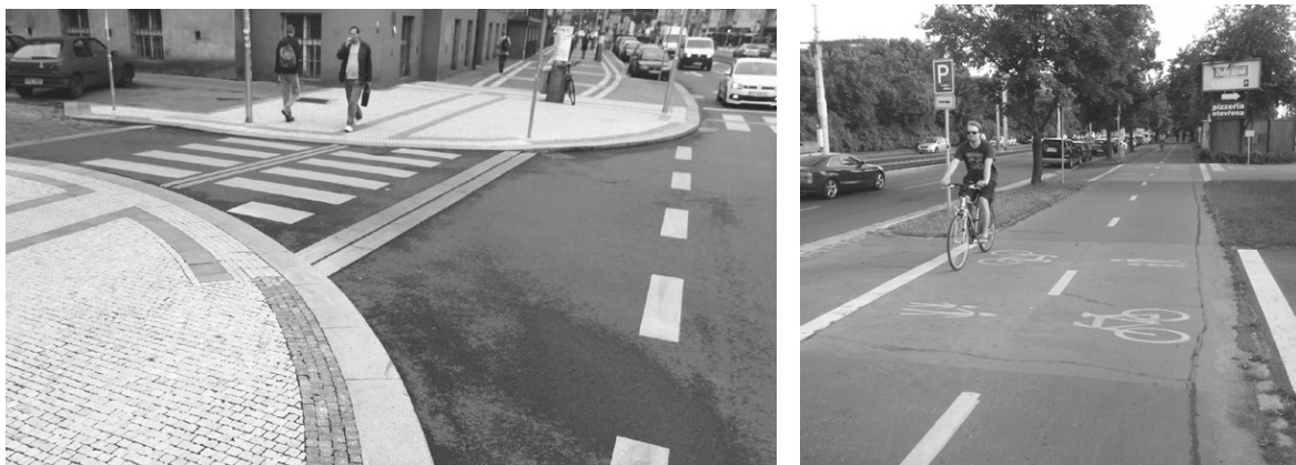
[ obr. 13 ] Příklad chodníkového přejezdu (vlevo) a stezkového přejezdu (vpravo)
