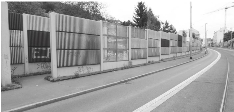
[ obr. 11 ] Protihlukové stěny v prostoru městské ulice, degradující charakter veřejného prostranství (Radlická ulice, Praha)
