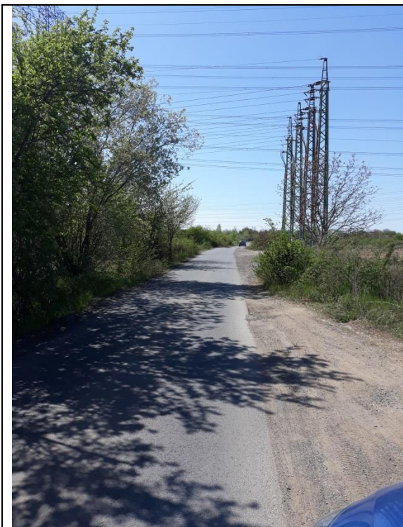
Foto č. 140324 – západní pohled z ulice V Ladech směrem ke Kunratické spojce, (pozn. platí i pro variantu V5)
