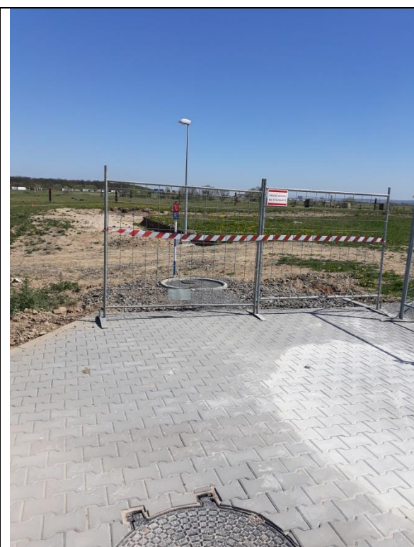
Foto č. 125214 – severovýchodní pohled na dálnici D1 z parcely 536/14, (pozn. platí i pro variantu V2, V2 a, V3b)
