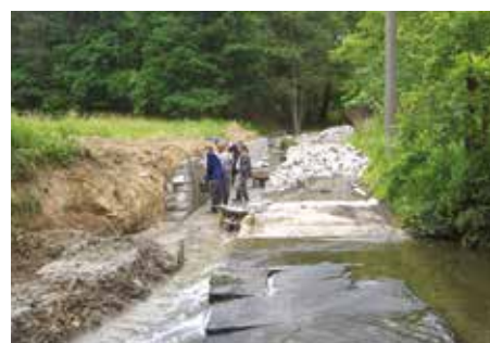
Stavba mostu – rok 2005
