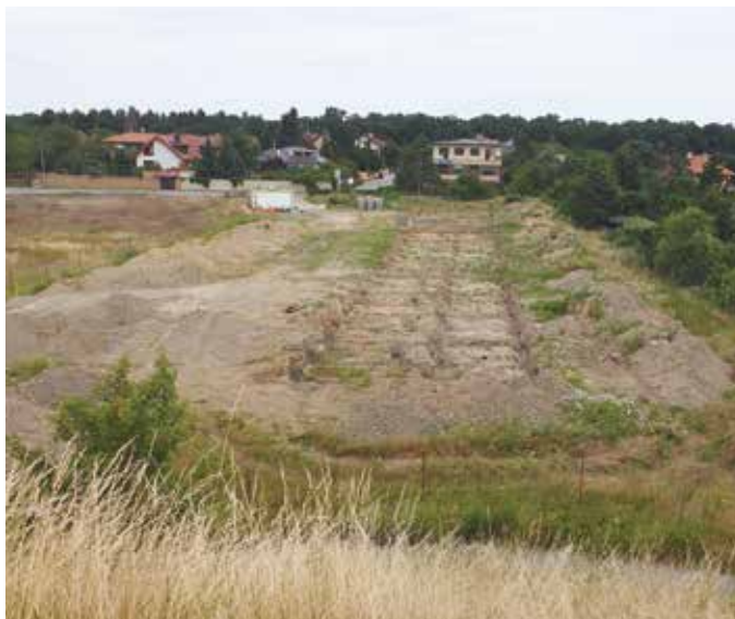
Stavba řadových rodinných domů GP Plus
