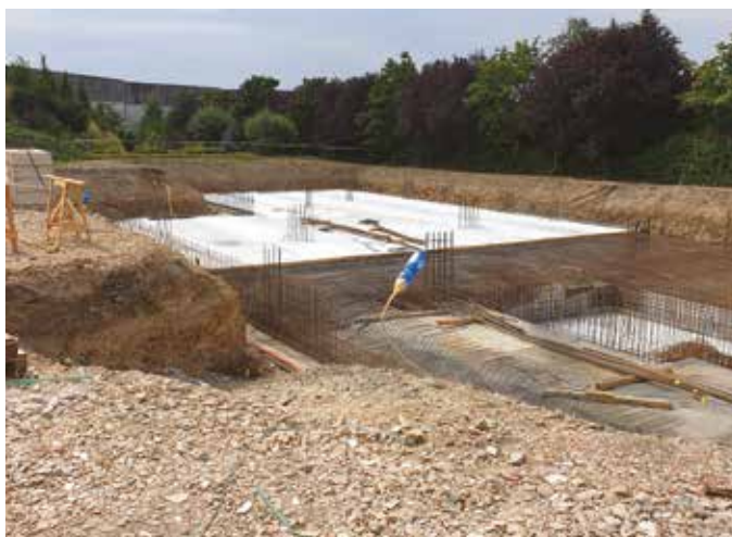
Stavba bytového domu Rezidence Stříbrná zahrada
