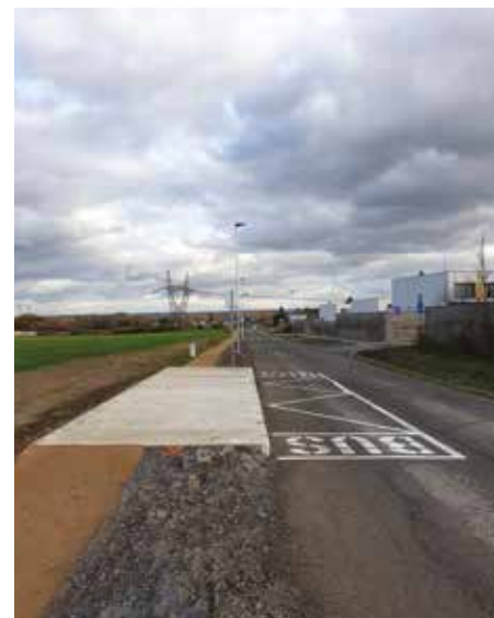
Autobusová zastávka Sukovská
