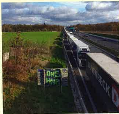
Místo pro stavbu protihlukové stěny v Újezdu
