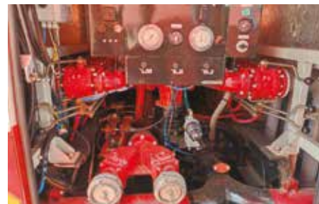
Stav po opravě
