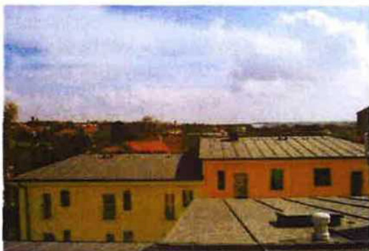
PVC folie Protan SE 1,6mm s navařovacími falci, Praha
