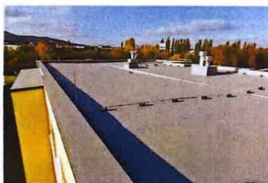
Rekonstrukce střešního pláště PVC folie Protan SE 1,6 mm Liberec Pilínkov
