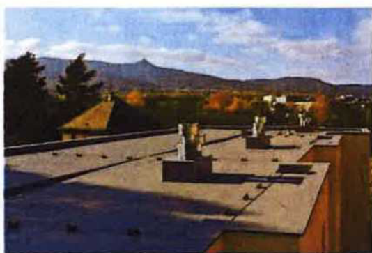
Rekonstrukce střešního pláště PVC folie Protan SE 1,6 mm Liberec Pilínkov
