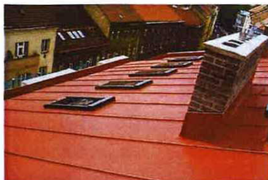
PVC folie Protan SE 1,6mm s navařovacími falci, Praha
